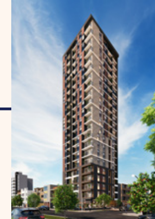
SUKHA EN CONSTRUCCIÓN
