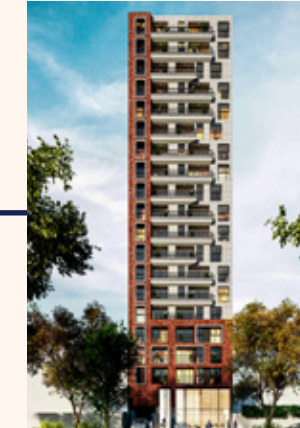
AURORA 4 EN CONSTRUCCIÓN
