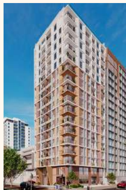
ASTRE EN CONSTRUCCIÓN
