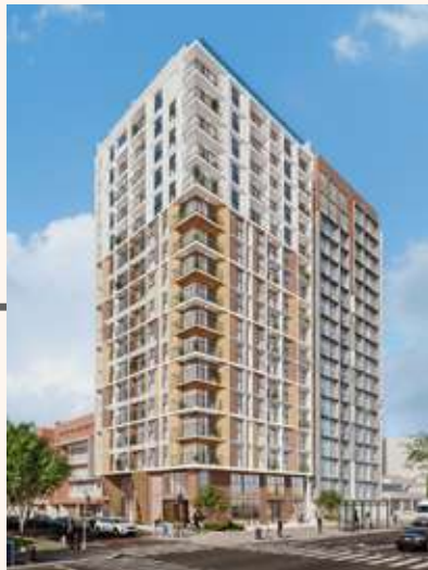
ASTRE EN CONSTRUCCIÓN
