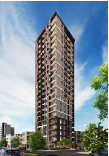
SUKHA EN CONSTRUCCIÓN
