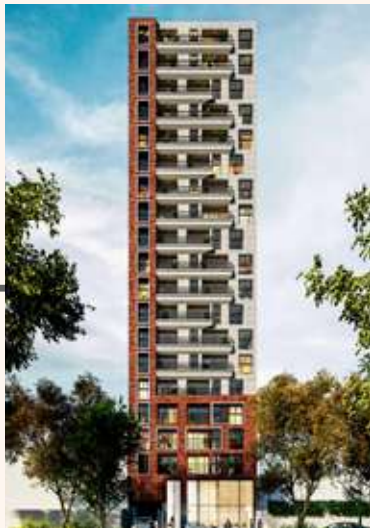
AURORA 4 EN CONSTRUCCIÓN
